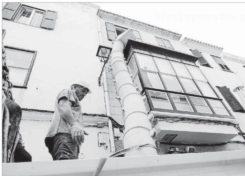
Un operario trabaja en la descarga de material de una vivienda en el centro de Maó. Foto: GEMMA ANDREU
